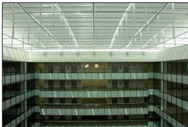
Figura 7.172 Detalhe clarabóia do átrio com persianas para fechamento
