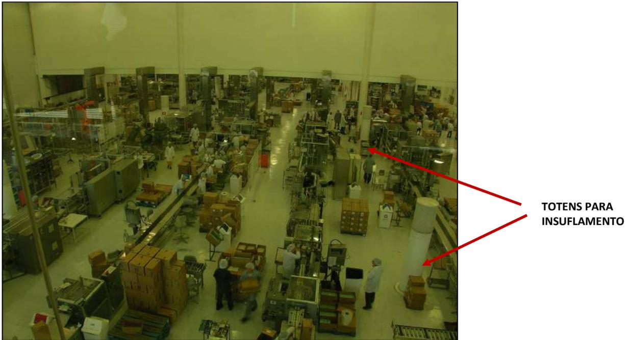
Figura 7.24 Vista interna da área de produção com os totens para insuflamento
