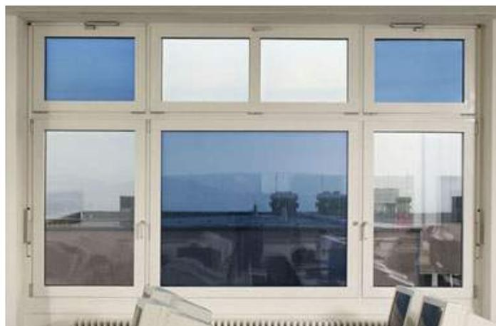
Figura 7.228 Vista interna de janela com Eletrocromicos
