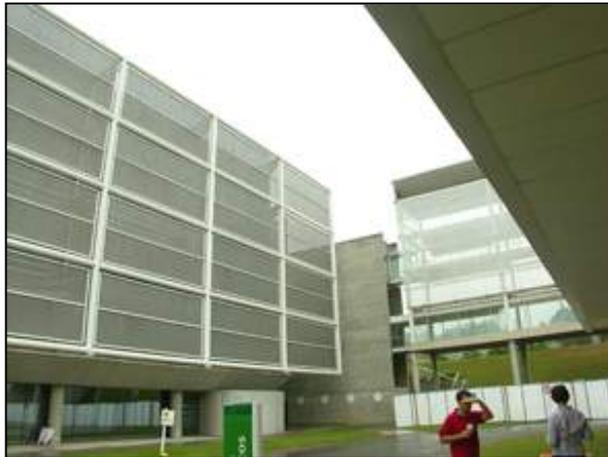
Figura 7.55 Presença do ritmo – fachada das passarelas e do prédio administrativo com proteção solar
