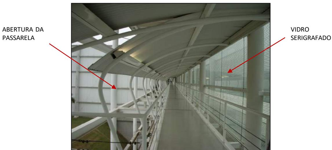
Figura 7.31 Vista interna da passarela de acesso aos edifícios de produção
