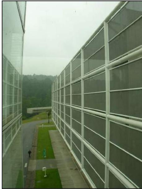
Figura 7.13 Fachada protegida com painéis de lona micro perfurada no bloco P&D
