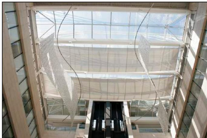
Figura 7.147 Teto da clarabóia, internamente com a proteção das telas.
