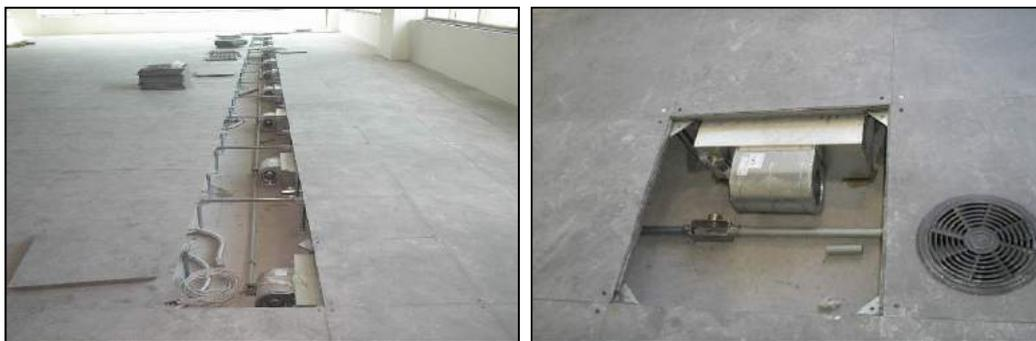
Figura 7.175 e Figura 176 Detalhes instalação Buster Fun
