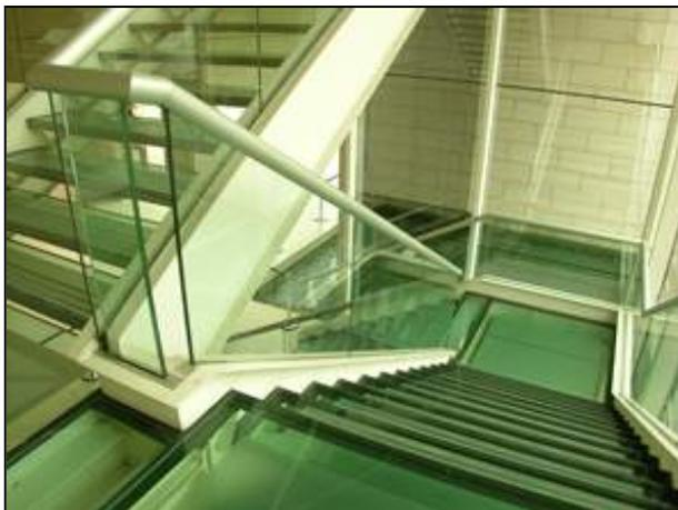
Figura 7.122 Detalhe escada com piso de vidro
