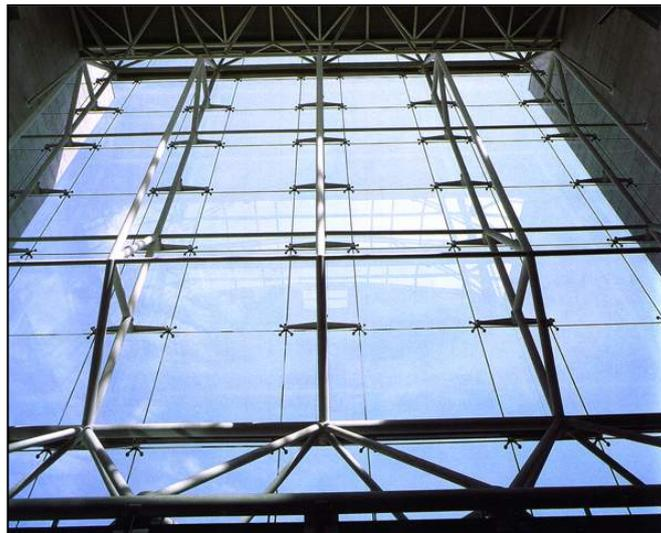
Figura 7.113 Detalhe da fixação dos vidros e garras
