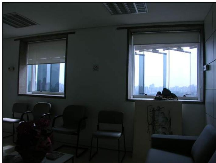
Figura 7.96 Vista interna dos brises de vidro
