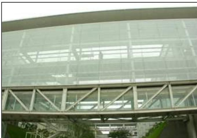
Figura. 7.15 Superfície de 307 m x 12 m, preenchida por vidros temperados serigrafados de 10 mm
