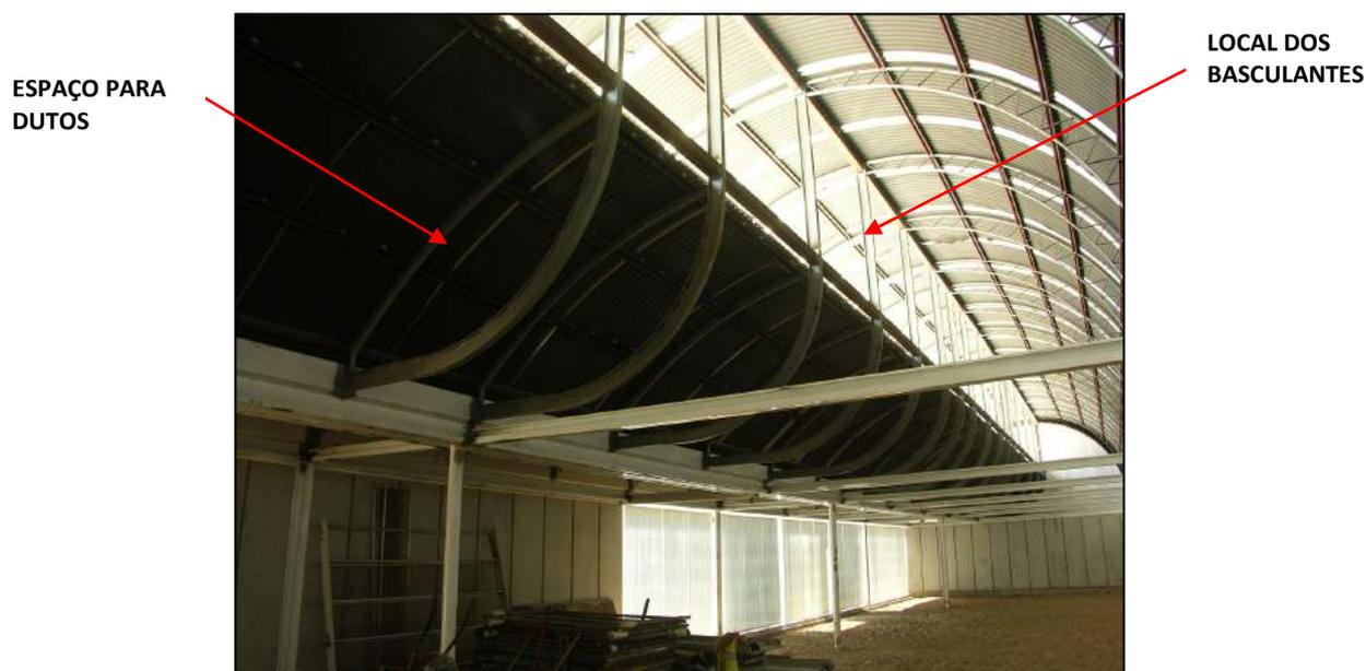
Figura 7.259 Estrutura interna dos Sheds
