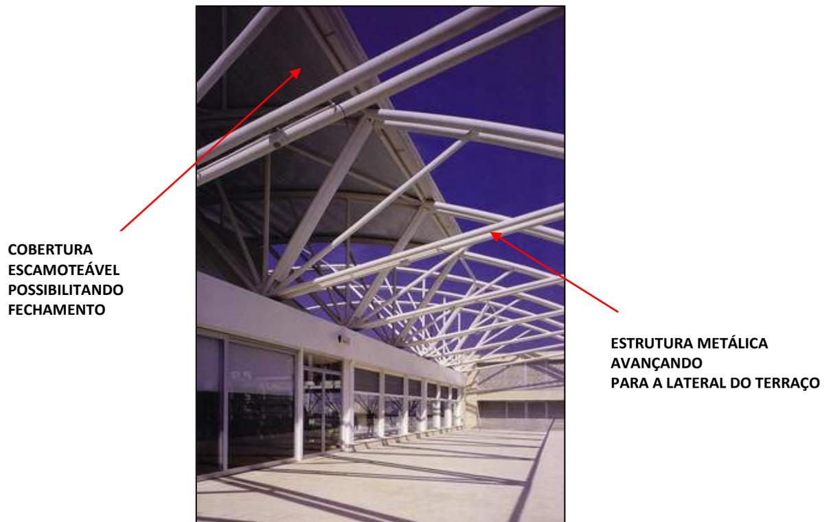
Figura 7.133 Áreas laterais externas com estrutura metálica
