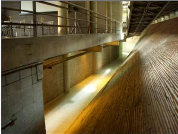
Figura 7.68 Talude Interno com lâminas de arenito vermelho
