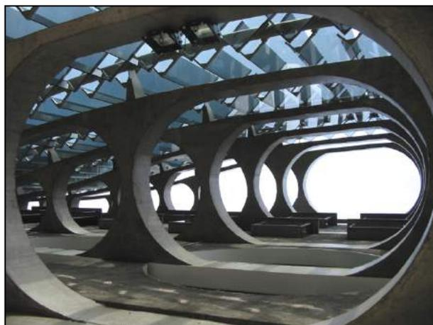
Figura 7.89 Brises – Vão que propicia a convecção do ar entre a fachada e o vidro
