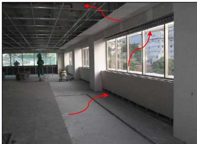
Figura 7.179 Detalhe peitoril com insuflamento e retorno pela cortina
